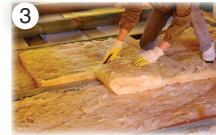
Yüzeyin yalıtım malzemesi ile kaplanması
